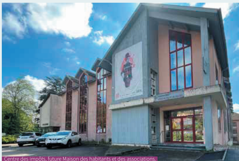
Centre des impôts, future Maison des habitants et des associations.
